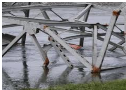
Kokkuvarisenud, värvitud konstruktsioon, mis on keevistest läbi roostetanud
